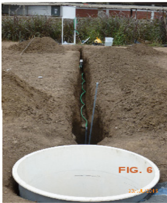
Figura 6. Tanques del equipo de lisímetro conectados y nivelados.
