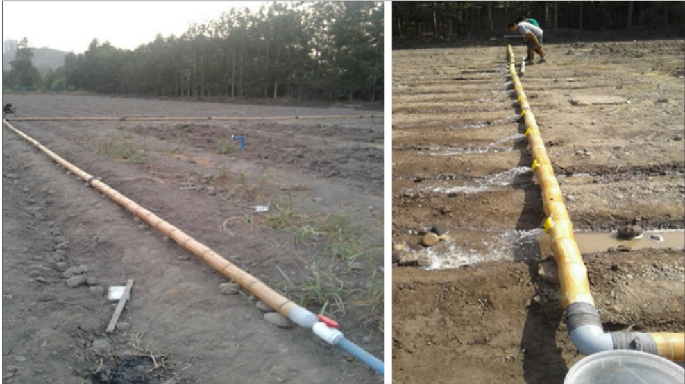
Figura 2: Instalación del sistema de riego de bambú en el campo experimental %
