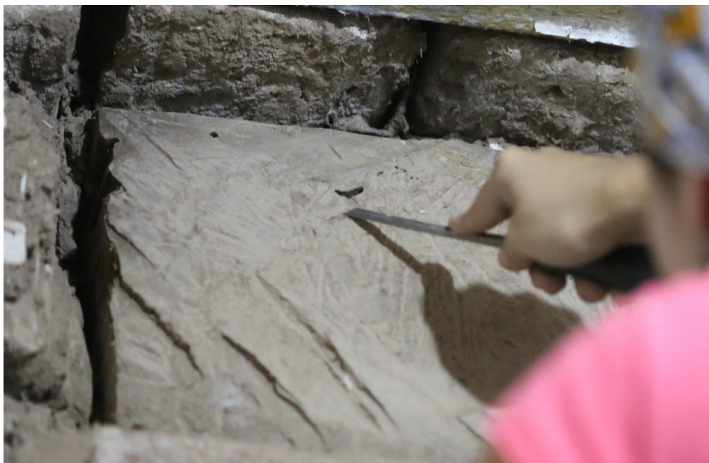
Figura 2. Inspección superficial de cabezales de vigas.
