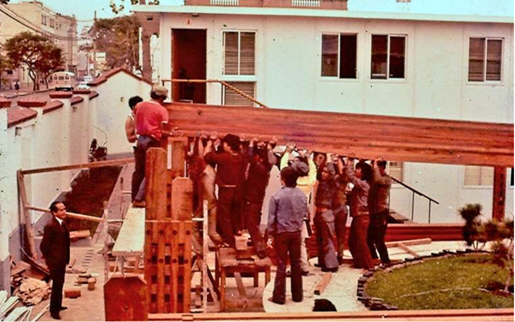
Figura 3. Montaje manual de viga de 13 m. Foto de Luis Takahashi.
