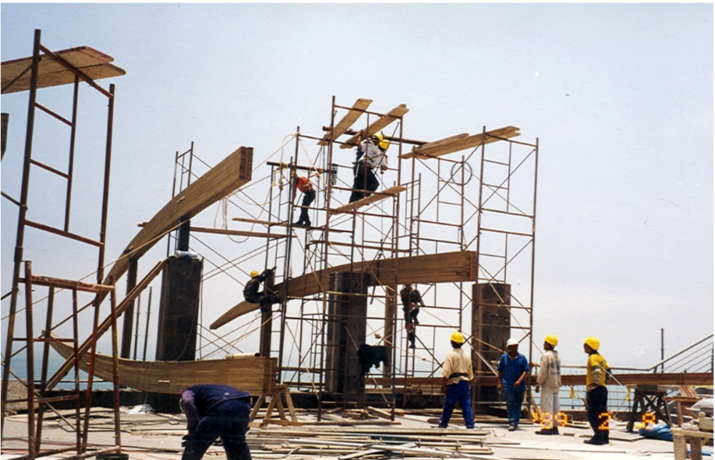
Figura 2. Montaje manual de vigas de 16 m. Foto de Luis Takahashi.
